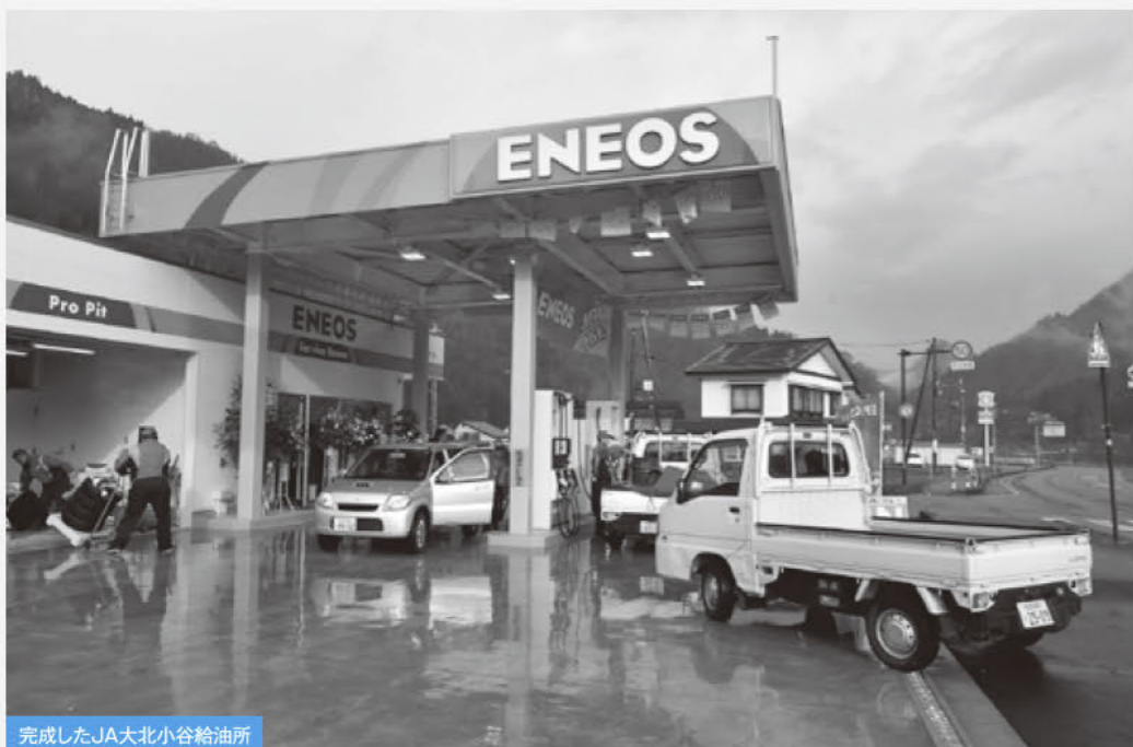
完成したJA大北小谷給油所
