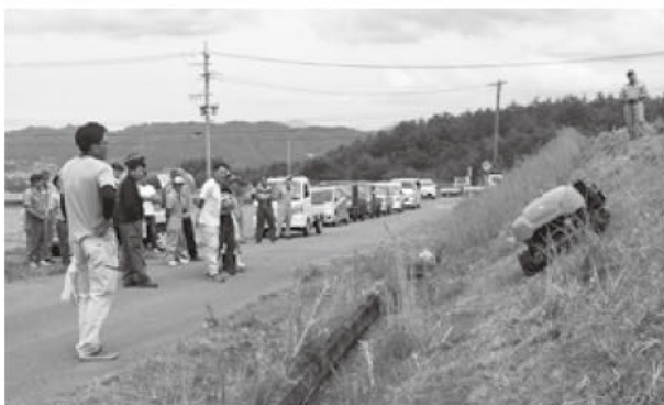
ラジコン操作で草刈り作業
