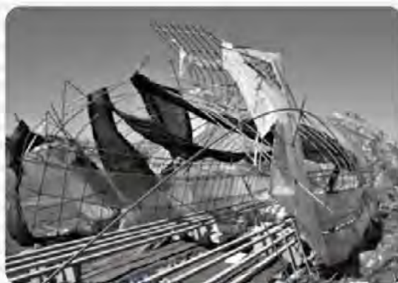
突風による被害
