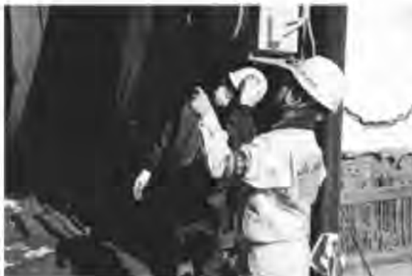
損害調査の様子
